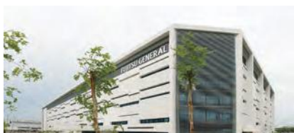
Centrum badawczo-rozwojowe w Fujitsu General Engineering (Tajlandia)
